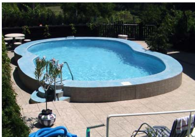
ABB. Becken teileingebaut, verkleidet
