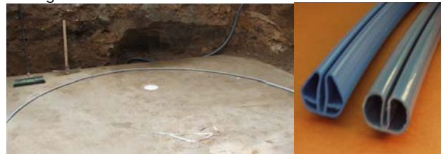
ABB. Bodenschienen auslegen
