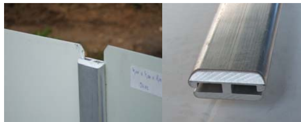
ABB. Steckschienenverbindung der Stahlwandenden
