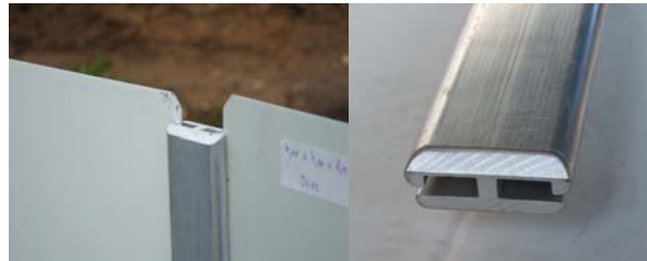
ABB. Steckschienenverbindung der Stahlwandenden
