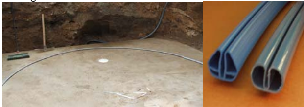
ABB. Bodenschienen auslegen
